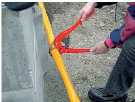
Abbildung 19 Rohrschere für SNRV
