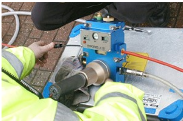
Abbildung 20 Beispiel für ein Einblasgerät für Minikabel
